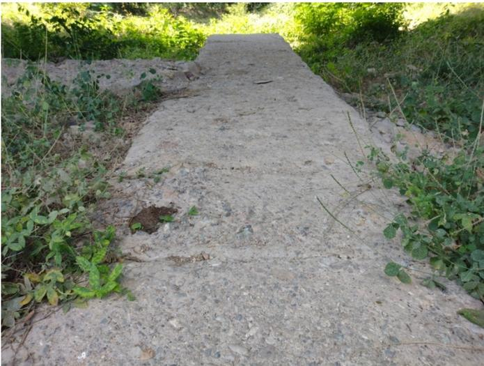
**Observaciones:** El box culvert es en concreto ciclópeo con dimensiones de 1.40 m x 1.40 m. Presenta pérdida de agregados, lavado de finos y socavación en la descarga.
