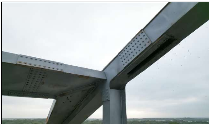
Ilustración 99 Vista de uniones arriostramiento arco
