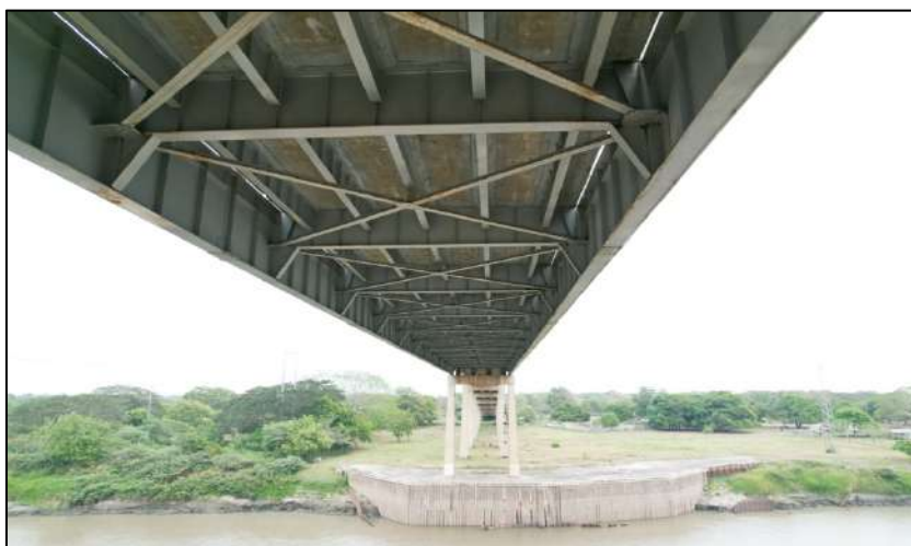
Ilustración 34 Vista inferior del puente
