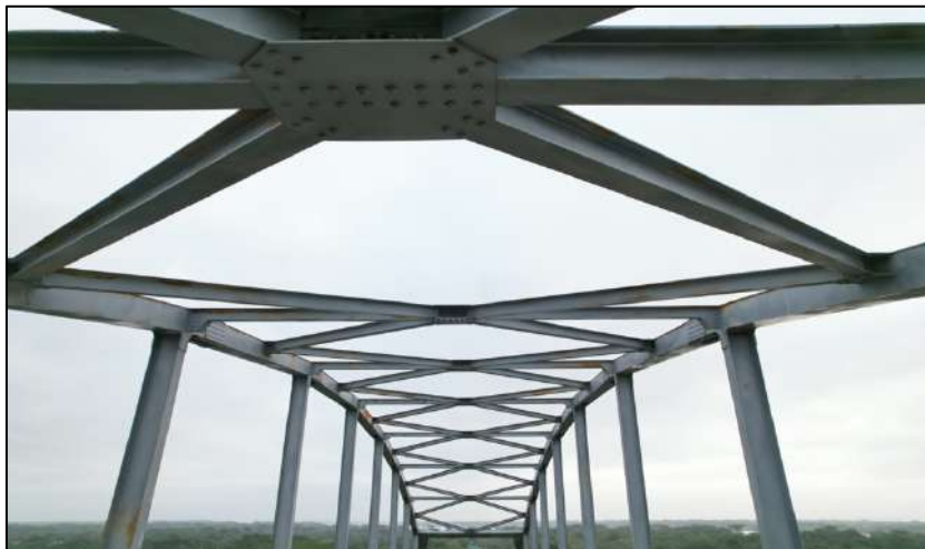
Ilustración 66 Vista general de arriostramiento
