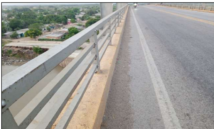
Ilustración 10 Vista de bordillos
