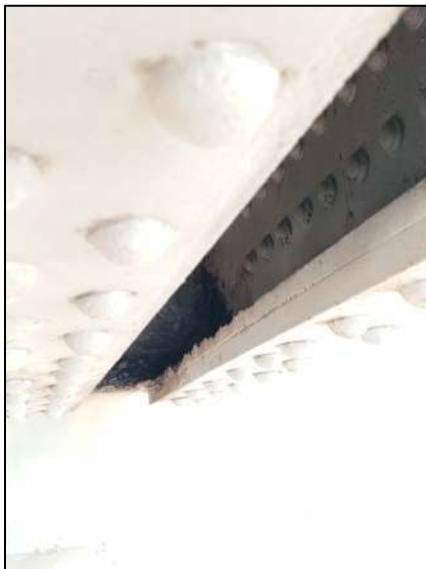
Ilustración 55 Pérdida de sección por corrosión
