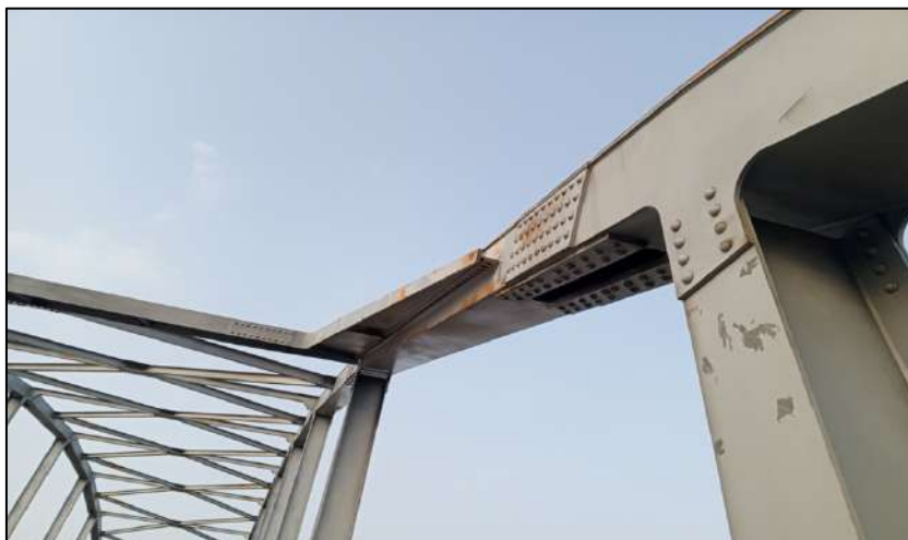
Ilustración 93 Vista de uniones en arco
