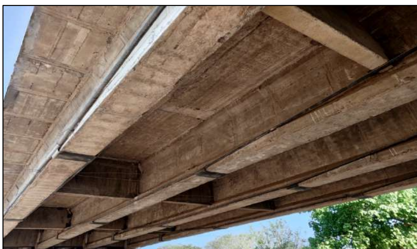
Ilustración 32 Biocapas y eflorescencias
