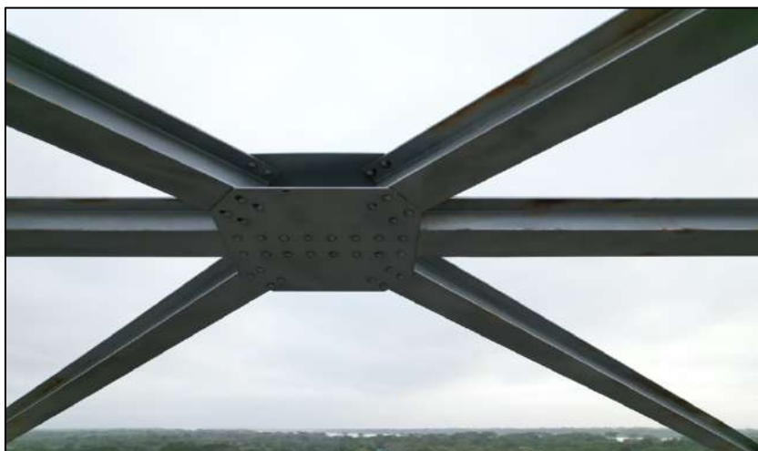
Ilustración 97 Vista de uniones arriostamiento arco
