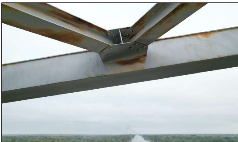
Ilustración 98 Vista de uniones arriostamiento arco
