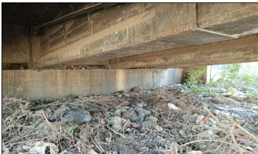
Ilustración 29 Vista de estribo sentido Calamar
