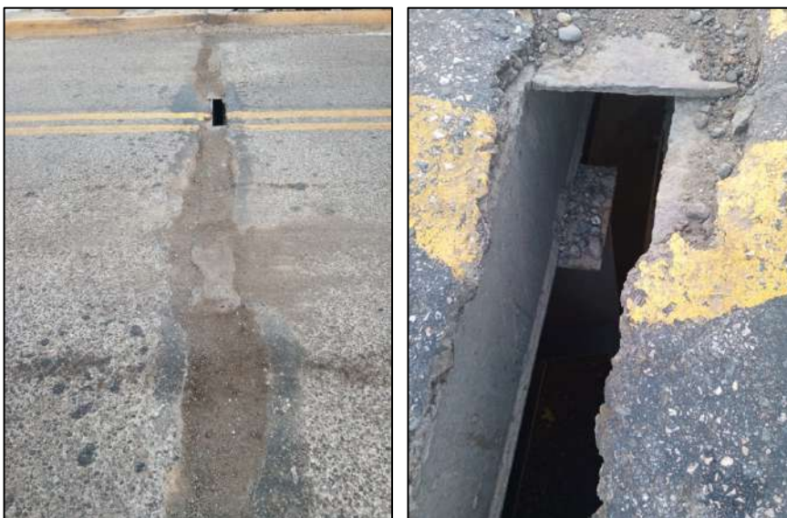
Ilustración 9 Vista de juntas de dilatación lado Calamar
