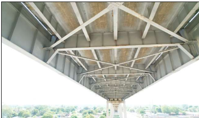
Ilustración 76 Vista inferior del puente
