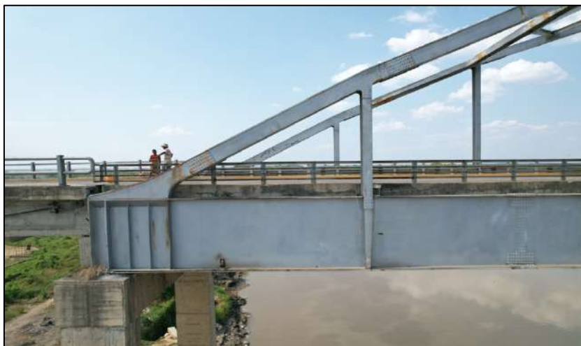
Ilustración 78 Vista de rigidizador
