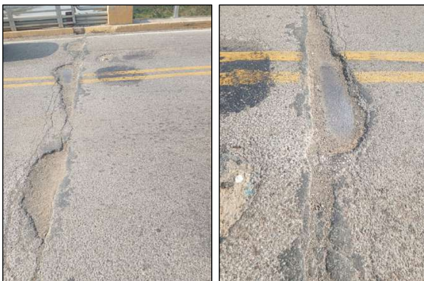
Ilustración 8 Vista de juntas de dilatación lado Barranquilla
