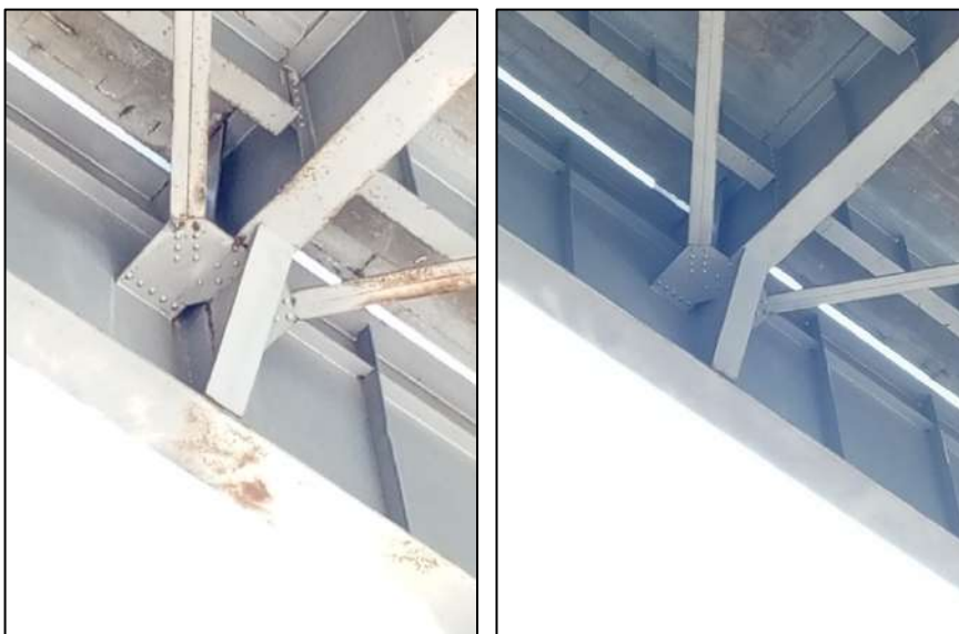
Ilustración 100 Vista de uniones arriostramiento
