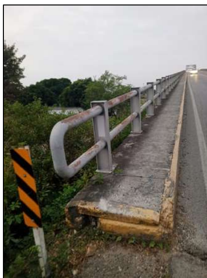
Ilustración 17 Vista de señalización horizontal
