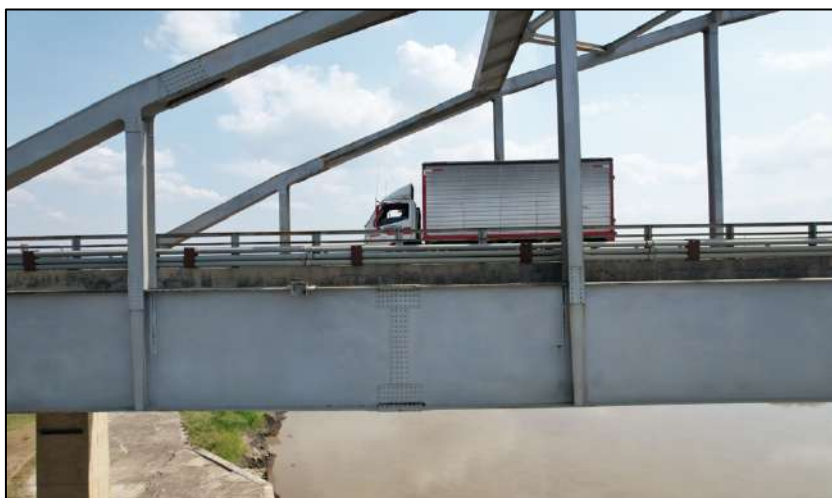
Ilustración 95 Vista de uniones costado izquierdo
