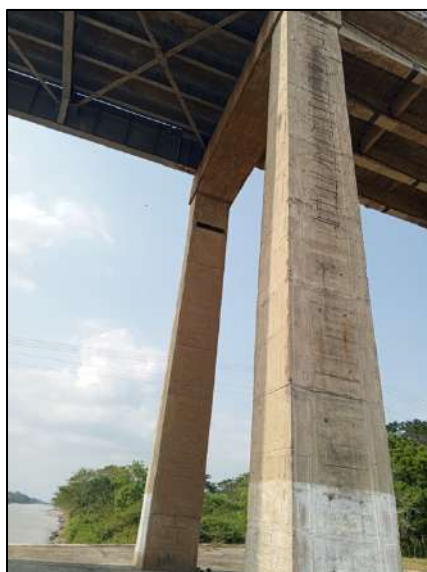
Ilustración 41 Vista general pila 2
