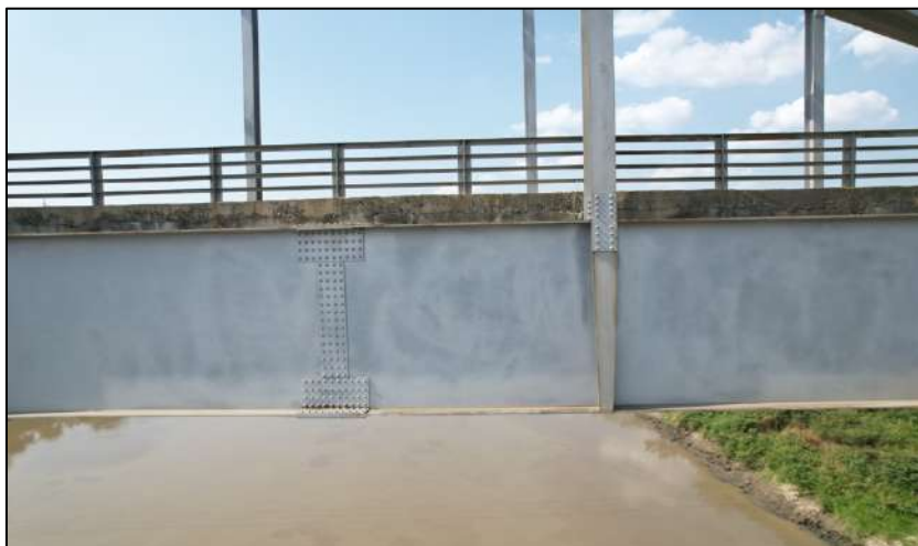
Ilustración 96 Vista de uniones costado derecho
