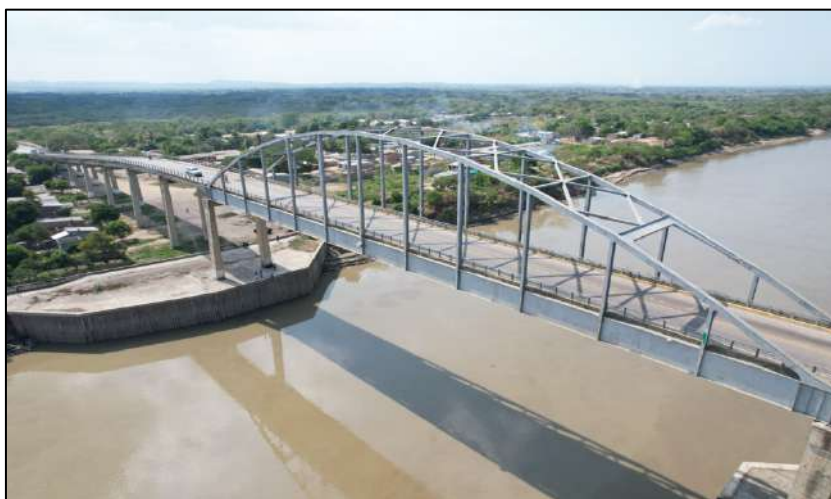
Ilustración 2 Vista lateral del puente
