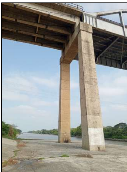
Ilustración 35 Vista general pila 1
