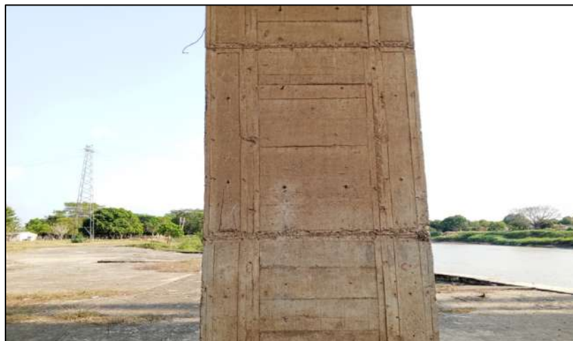
Ilustración 43 Juntas frías en pila 2
