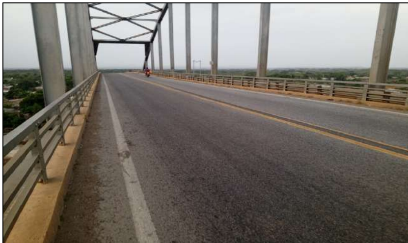
Ilustración 16 Vista de señalización horizontal
