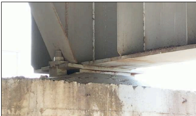
Ilustración 52 Vista de apoyo lado Calamar
