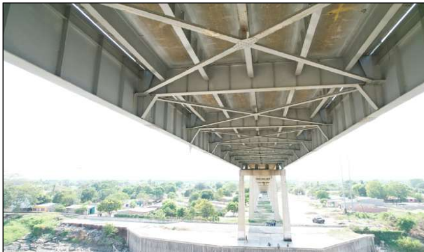
Ilustración 4 Vista inferior del puente
