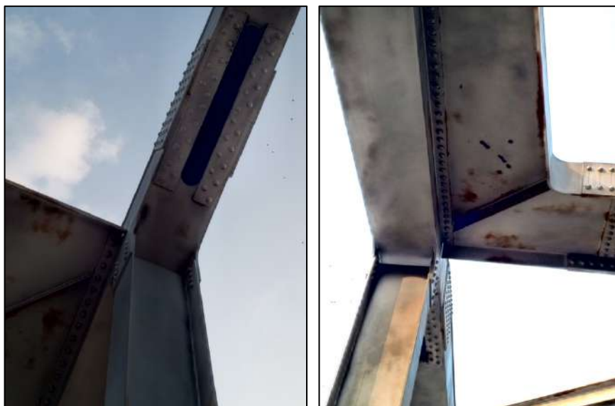
Ilustración 92 Vista de uniones en arco
