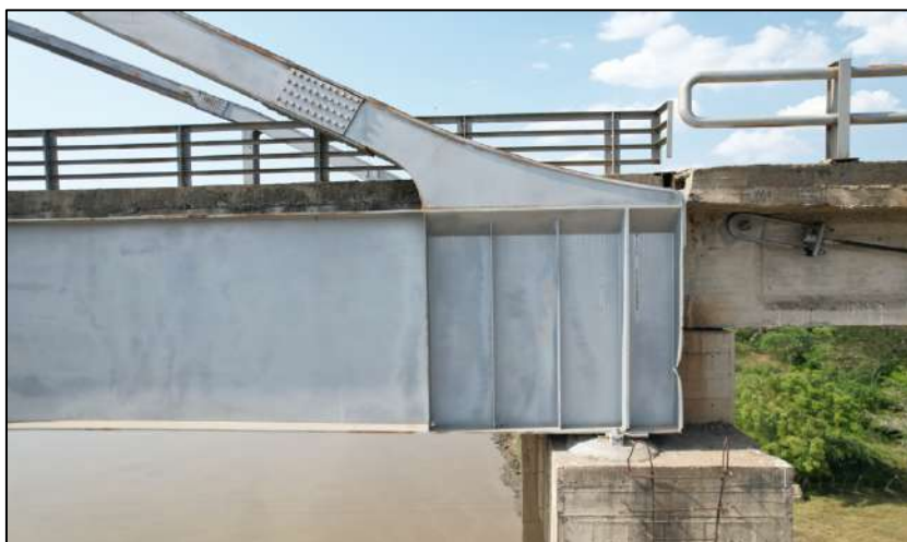
Ilustración 77 Vista de rigidizador
