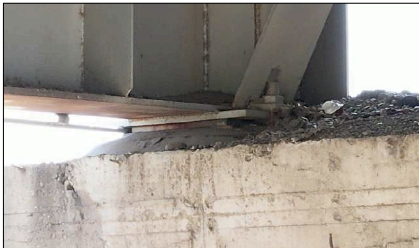
Ilustración 51 Vista de apoyo lado Calamar
