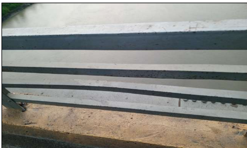
Ilustración 13 Deformación de elemento longitudinal
