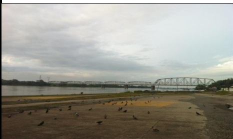
FOTO 3: VISTA PANORÁMICA LONGITUDINAL
