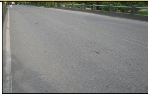
FOTO 2: PLACA IDENTIFICACIÓN PUENTE - NO EXISTE
