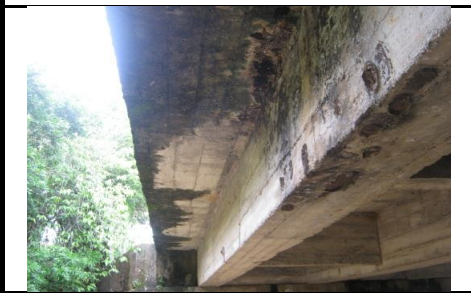
FOTO 3: VISTA PANORAMICA LONGITUDINAL
