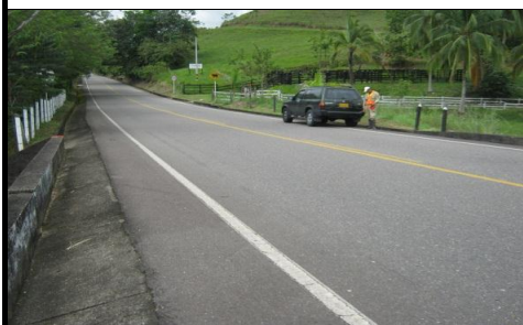
FOTO 3: VISTA PANORAMICA LONGITUDINAL
