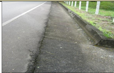
FOTO 2: PLACA IDENTIFICACIÓN PUENTE (no existe)
