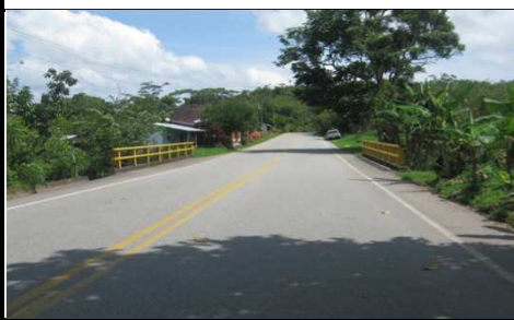
FOTO 3: VISTA PANORAMICA LONGITUDINAL
