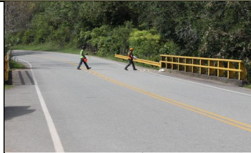
FOTO 2: PLACA IDENTIFICACION PUENTE-NO EXISTE
