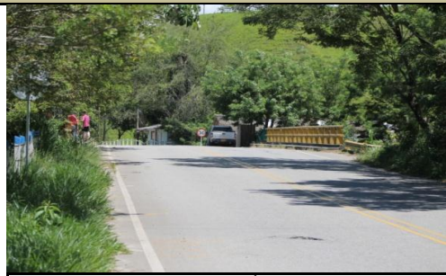
FOTO 2: PLACA IDENTIFICACIÓN PUENTE-NO EXISTE
