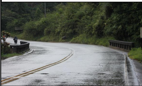
FOTO 3: VISTA PANORAMICA LONGITUDINAL
