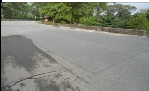
FOTO 3: VISTA PANORAMICA LONGITUDINAL
