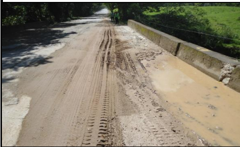
FOTO 3: VISTA PANORAMICA LONGITUDINAL
