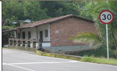
FOTO 2: PLACA IDENTIFICACIÓN PUENTE-NO EXISTE
