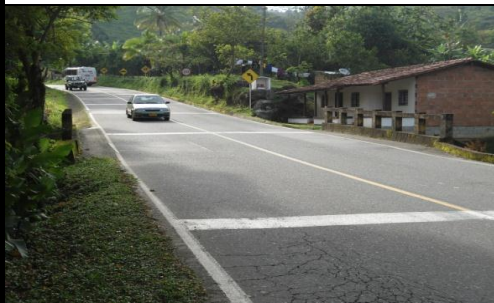
FOTO 3: VISTA PANORAMICA LONGITUDINAL
