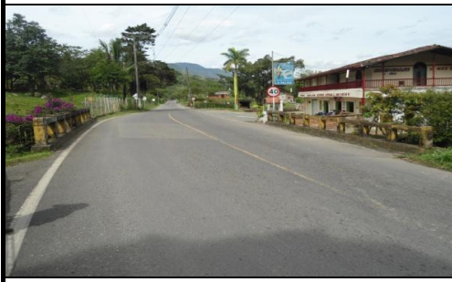
FOTO 3: VISTA PANORÁMICA LONGITUDINAL
