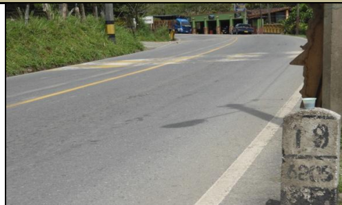
FOTO 2: PLACA IDENTIFICACIÓN PUENTE - NO EXISTE
