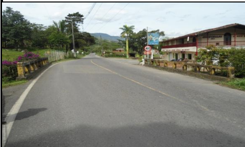
FOTO 3: VISTA PANORAMICA LONGITUDINAL
