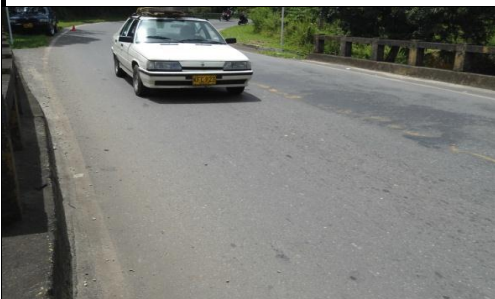
FOTO 3: VISTA PANORAMICA LONGITUDINAL
