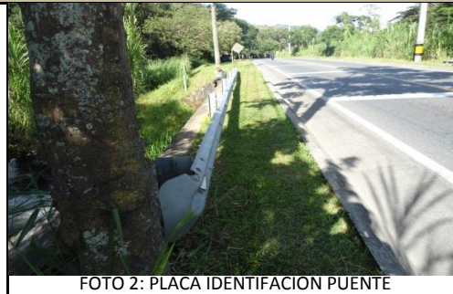
FOTO 2: PLACA IDENTIFICACION PUENTE
