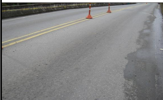
FOTO 3: VISTA PANORAMICA LONGITUDINAL
