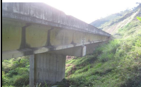
FOTO 3: VISTA PANORAMICA LONGITUDINAL
