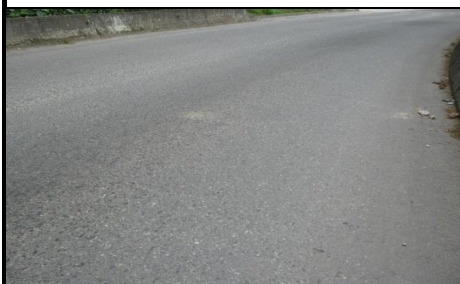
FOTO 3: VISTA PANORAMICA LONGITUDINAL
