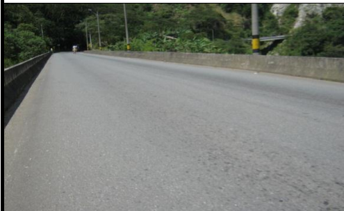
FOTO 3: VISTA PANORÁMICA LONGITUDINAL
