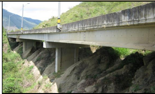
FOTO 2: PLACA IDENTIFICACIÓN PUENTE-NO EXISTE
