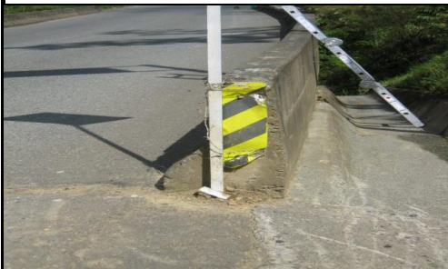
FOTO 3: VISTA PANORAMICA LONGITUDINAL
