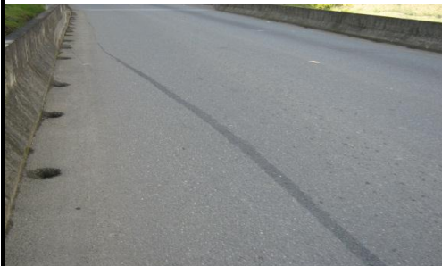
FOTO 3: VISTA PANORÁMICA LONGITUDINAL
