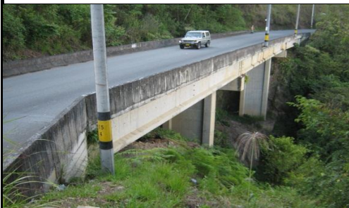
FOTO 3: VISTA PANORÁMICA LONGITUDINAL
