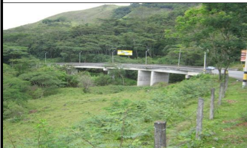
FOTO 3: VISTA PANORÁMICA LONGITUDINAL
