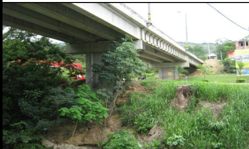
FOTO 3: VISTA PANORÁMICA LONGITUDINAL
