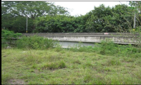
FOTO 3: VISTA PANORAMICA LONGITUDINAL
