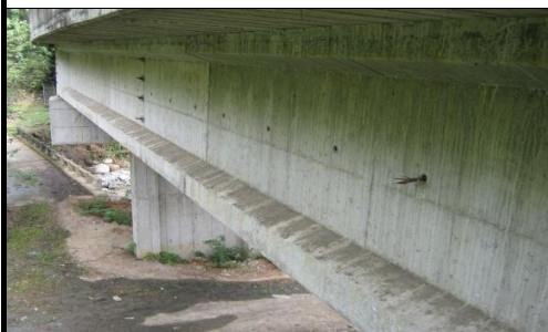
FOTO 3: VISTA PANORAMICA LONGITUDINAL
