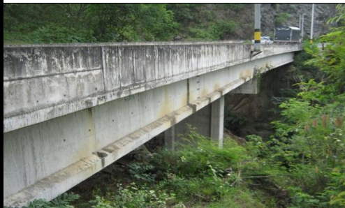
FOTO 3: VISTA PANORÁMICA LONGITUDINAL
