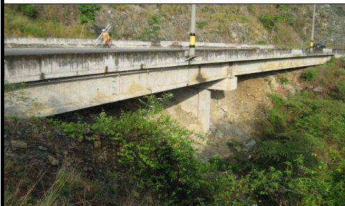
FOTO 3: VISTA PANORAMICA LONGITUDINAL
