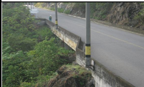
FOTO 3: VISTA PANORAMICA LONGITUDINAL
