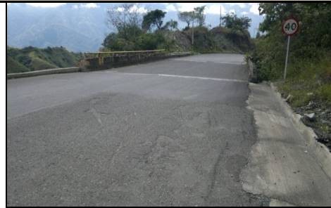
FOTO 2: PLACA IDENTIFICACIÓN PUENTE-NO EXISTE
