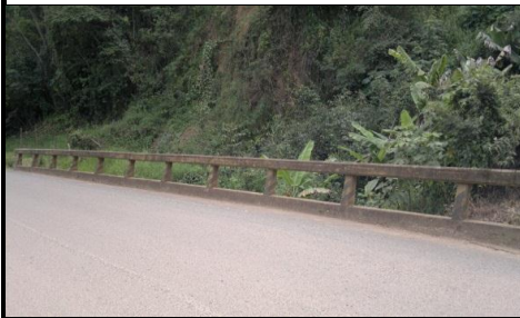
FOTO 3: VISTA PANORÁMICA LONGITUDINAL
