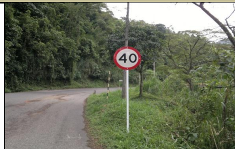
FOTO 2: PLACA IDENTIFICACIÓN PUENTE- NO EXISTE
