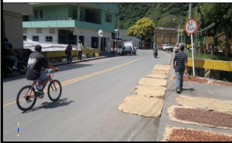
FOTO 3: VISTA PANORAMICA LONGITUDINAL
