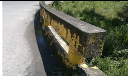
FOTO 2: PLACA IDENTIFICACIÓN PUENTE - NO EXISTE
