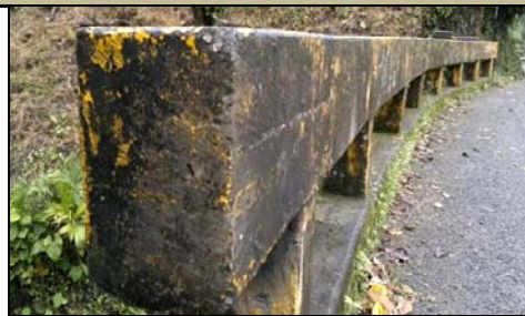
FOTO 2: PLACA IDENTIFICACIÓN PUENTE - NO EXISTE
