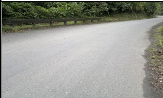
FOTO 3: VISTA PANORAMICA LONGITUDINAL
