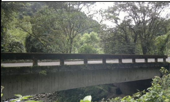
FOTO 3: VISTA PANORAMICA LONGITUDINAL
