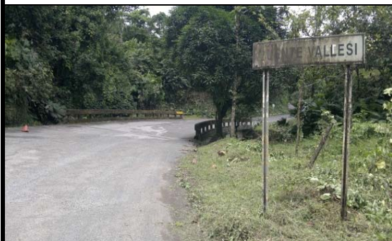
FOTO 3: VISTA PANORÁMICA LONGITUDINAL
