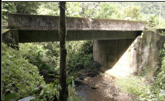
FOTO 3: VISTA PANORAMICA LONGITUDINAL
