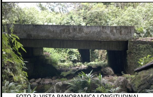
FOTO 3: VISTA PANORAMICA LONGITUDINAL
