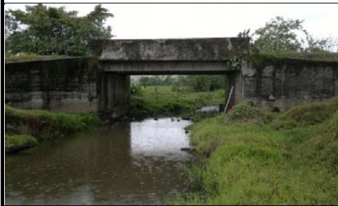
FOTO 3: VISTA PANORAMICA LONGITUDINAL
