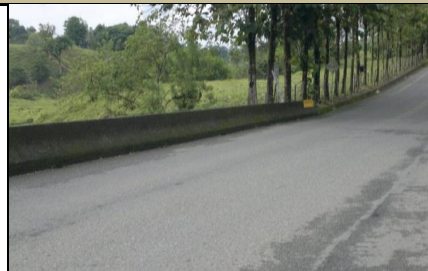
FOTO 2: PLACA IDENTIFICACIÓN PUENTE (NO EXISTE)
