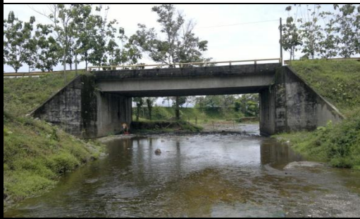
FOTO 3: VISTA PANORAMICA LONGITUDINAL
