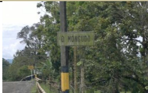
FOTO 2: PLACA IDENTIFICACIÓN PUENTE
