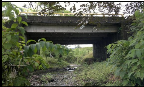
FOTO 3: VISTA PANORAMICA LONGITUDINAL
