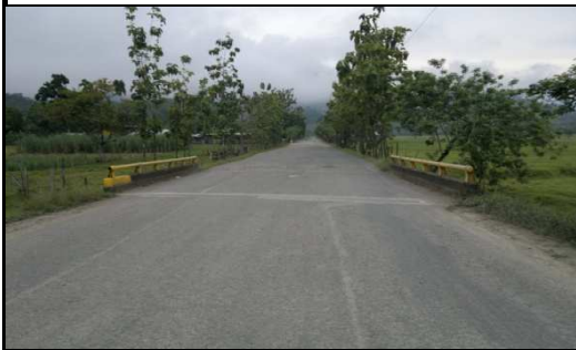
FOTO 3: VISTA PANORÁMICA LONGITUDINAL
