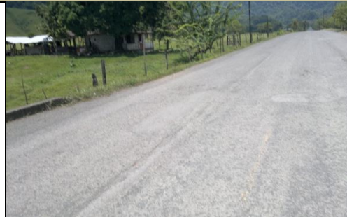
FOTO 2: PLACA IDENTIFICACIÓN PUENTE (NO EXISTE)
